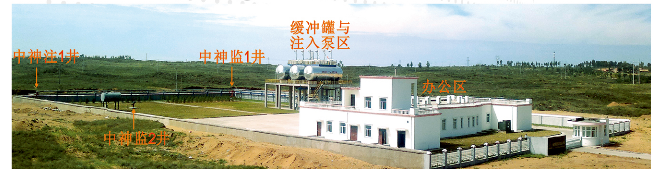
神华集团深部咸水层二氧化碳地质储存工程场地
